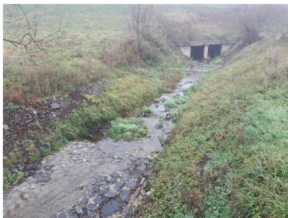
Foto 2: Úsek 1 – pohled po vodě na kavernu ve dně a propustek vedoucí pod silnicí I/62
