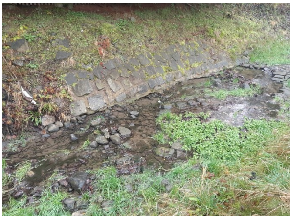
Foto 13: Úsek 5 – Pohled na porušené opevnění dna a opevnění pravého břehu v bezprostřední blízkosti před pařezem z Foto 12
