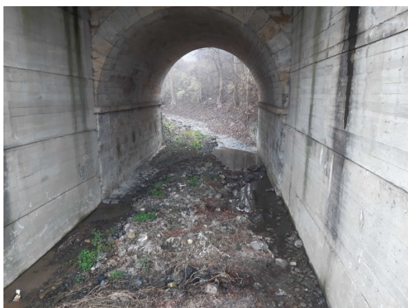
Foto 5: Odtěžení – Pohled proti vodě na štěrkový nános pod železničním mostem
