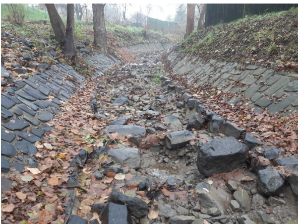
Foto 10: Úsek 4 – Pohled po vodě z přímé části na pravotočivý oblouk včetně způsobených škod ve dně a stromů narušujících opevnění levého břehu
