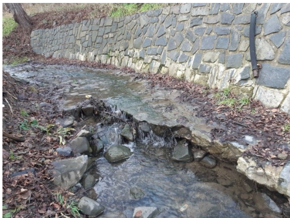
Foto 15: Úsek 6 – Detail kaverny ve dně začínající cca v poslední 1/3 oblouku (pohled proti vodě)
