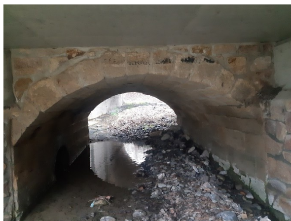
Foto 4: Odtěžení – Pohle proti vodě na štěrkový nános pod silničním mostem a navazující železniční most
