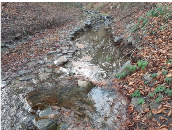
Foto 22: Úsek 8 – Pohled proti vodě, kaverna v historické dlažbě, cca 4 m po proudu pod jejím koncem vznikne beton-kamenný stabilizační pas
