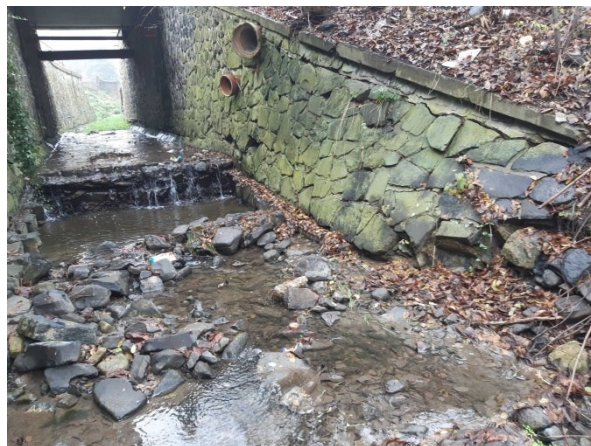
Foto 20: Úsek 7 – Pohled na narušenou opěrnou zeď levého břehu a vzniklého stupně ve dně
