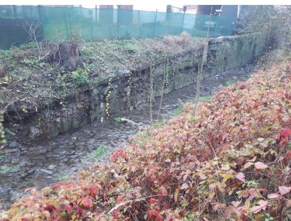
Foto 18: Úsek 7 – Pohled na vypadané zdivo opěrné zdi pravého břehu
