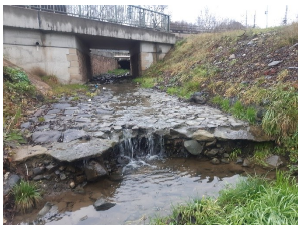
Foto 3: Úsek 1 – Detail vzniklého stupně ve dně, začátek kaverny (pohled proti vodě)
