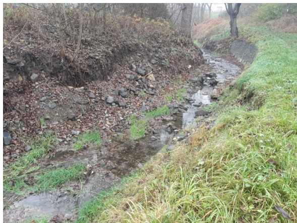
Foto 14: Úsek 6 – Pohled proti vodě na kavernu ve dně, levý břeh opevněný opěrnou zdí, v pravém břehu zasahuje do toku vzrostlý strom, bude odstraněn
