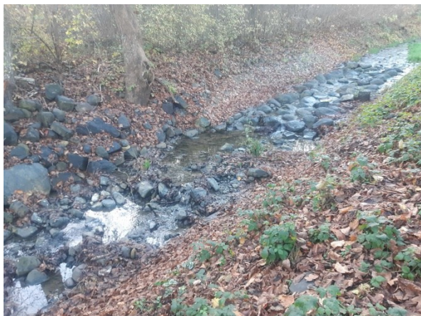
Foto 7: Úsek 3 – Porušené dno pod balvanitým skluzem, část opevnění vynesena na pravý břeh (pohled proti vodě)
