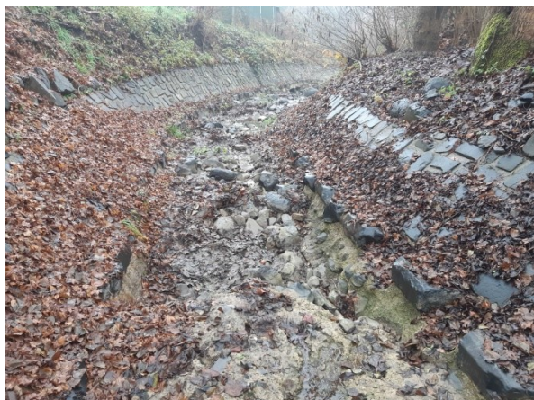
Foto 9: Úsek 4 – Pohled po vodě na pravotočivý oblouk, narušené a z velké části odplavené opevnění dna
