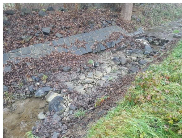
Foto 6: Úsek 2 – Porušené opevnění dna. Cca v profilu stromu bude vybudován stabilizační betonový pas, ve stejném profilu bude začínat ochranný zemní val, strom bude odstraněn
