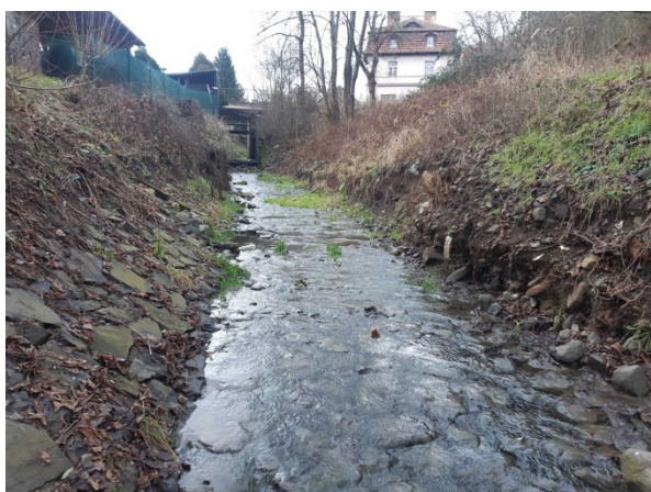
Foto 17: Úsek 6 – Pohled proti vodě, původní opevnění a schodiště v pravém břehu, podemletý a nestabilní levý břeh tvořený nánosem
