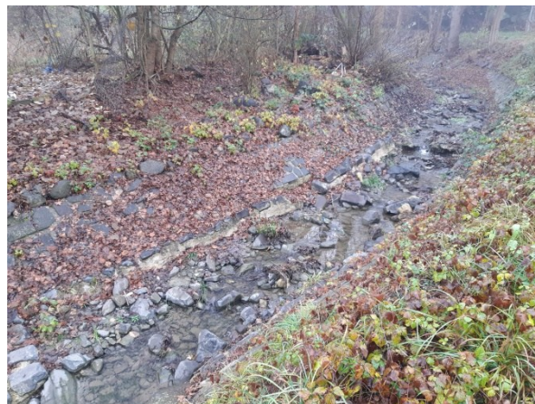
Foto 8: Úsek 4 – Pohled na oblouk proti vodě, narušené opevnění dna
