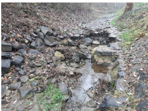
Foto 11: Úsek 4 – Pohled proti vodě, začátek kaverny, zbytek stabilizačního pasu
