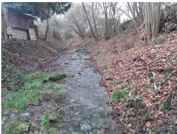
Foto 21: Úsek 8 – Pohled proti vodě na profil, kde vznikne nový stabilizační beton-kamenný pas, kaverna v dlažbě, nepovolená stavba na pravém břehu
