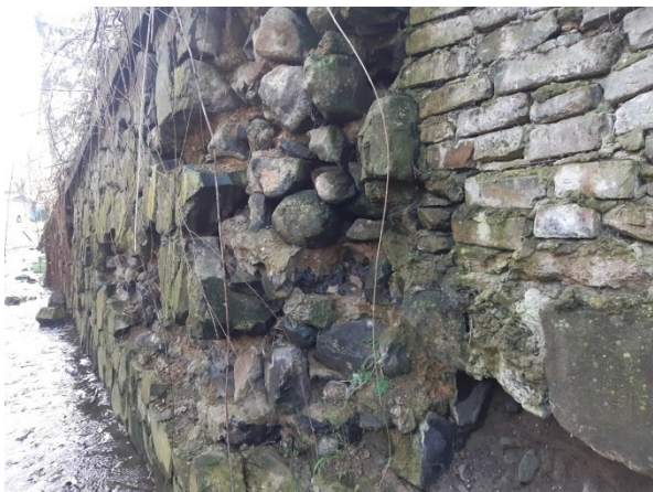
Foto 19: Úsek 7 – Detail zdiva pravé opěrné zdi, pohled na původní zazděné schodiště
